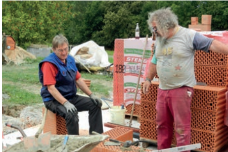
2014/15 Neubau Grillbude, Schiedsrichterraum und Bällerraum
