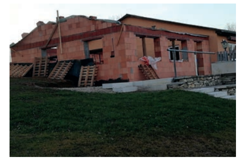
Dart Raum Rohbau
