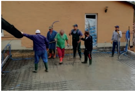
Betonieren Bodenplatte Dart Raum
