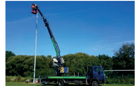
2018 neuer Flutlicht Mast (Vergelt's Gott der kleinen Zimmerei, Wöllmetzhofen)
